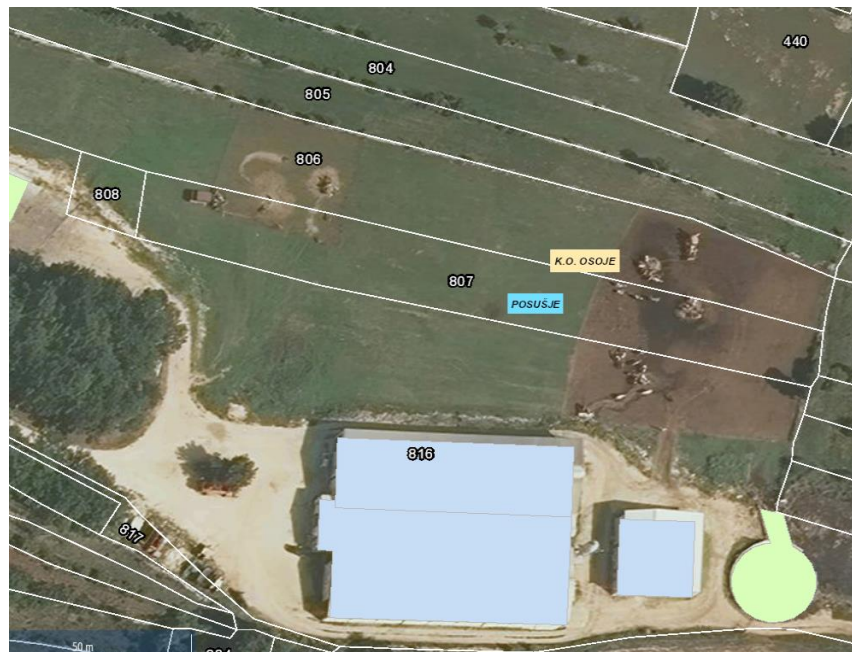
Slika 1. Prikaz lokacija/parcele postojećeg objekta i k.č. 806, 807 i 808 planirane nadogradnje
