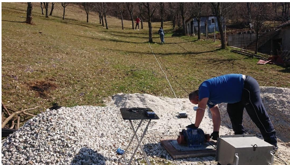
Slika 198: Tačka 4 (kod stope Vijadukta 6, Tunela T2 i u naselju Mladeškovići) km 6+700
