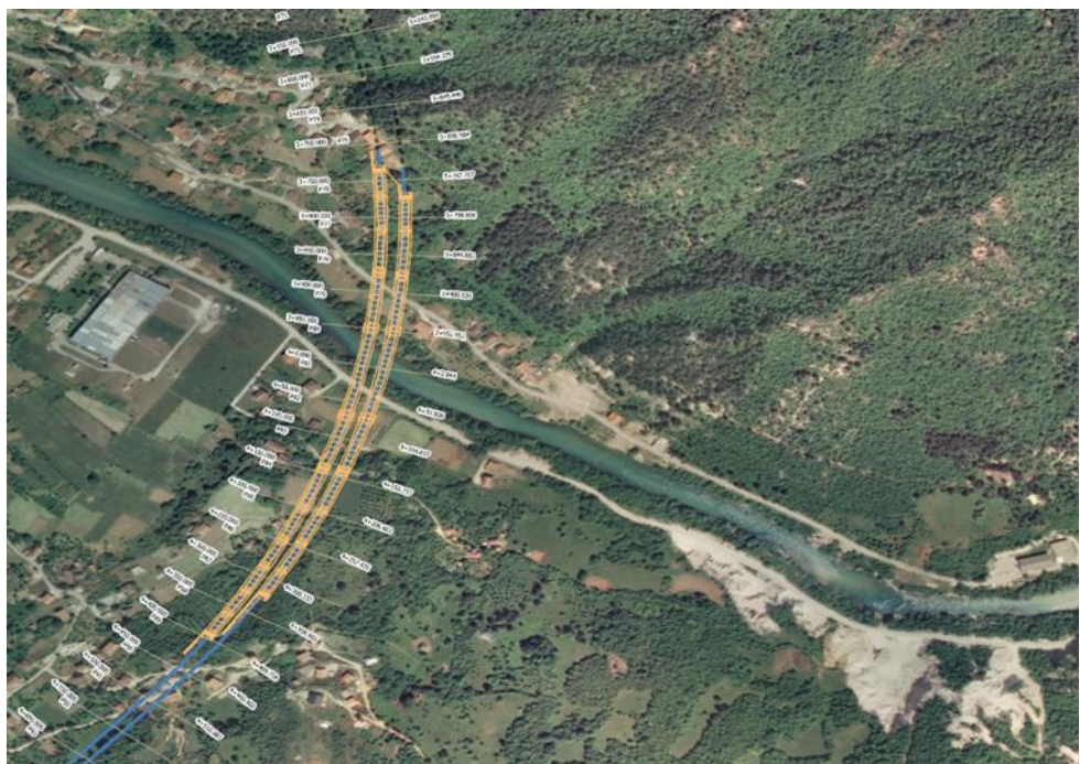
Slika 295: Vibracijsko žarište #2 - vijadukt 3 i južni portal tunela T-1
