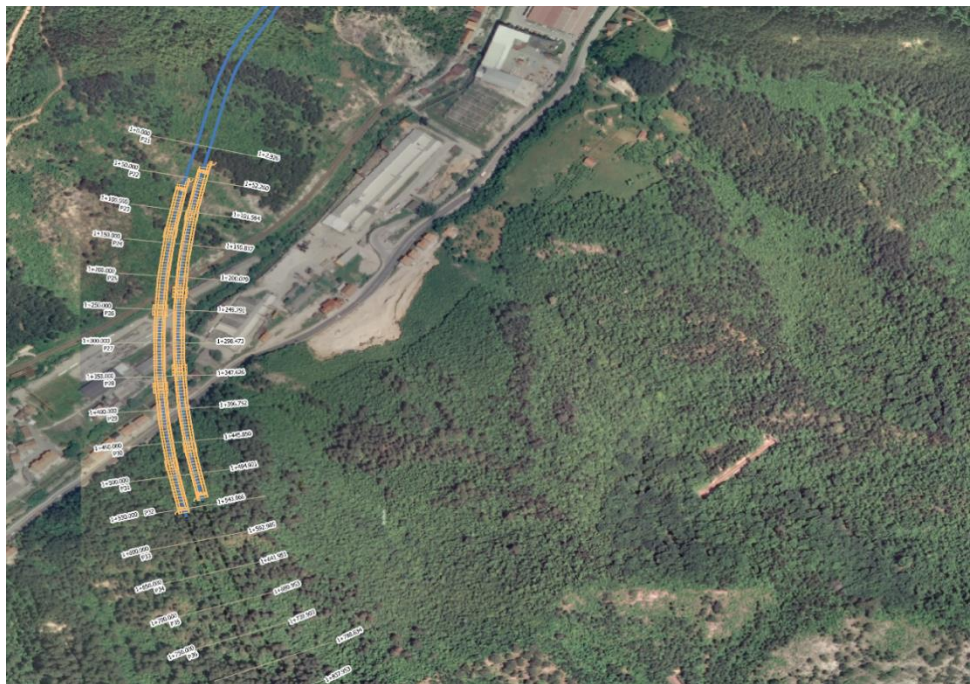
Slika 294: Vibracijsko žarište #1 - vijadukt 2 i sjeverni portal tunela T-1
