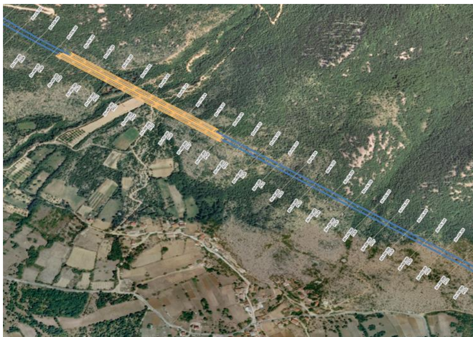
Slika 298: Vibracijsko žarište #6- vijadukt ~ 24+250
