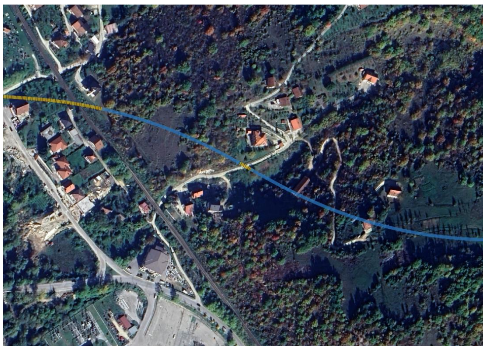
Slika 314: Vibracijsko žarište #8 - vijadukt na obilaznici Konjic ~0+760
