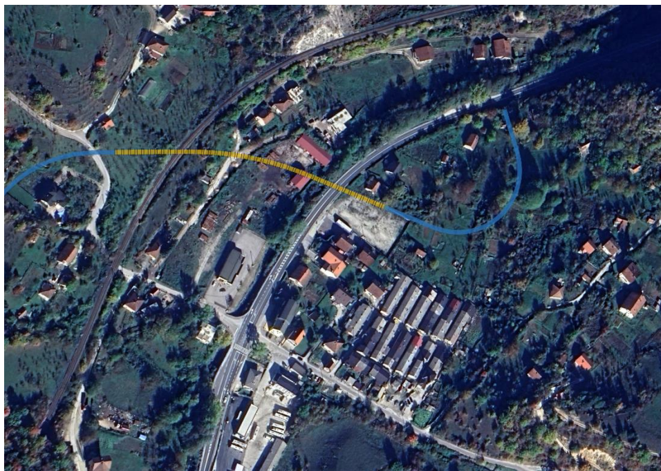
Slika 313: Vibracijsko žarište #7 - vijadukt na pristupnom putu za Konjic Sjever I/C
