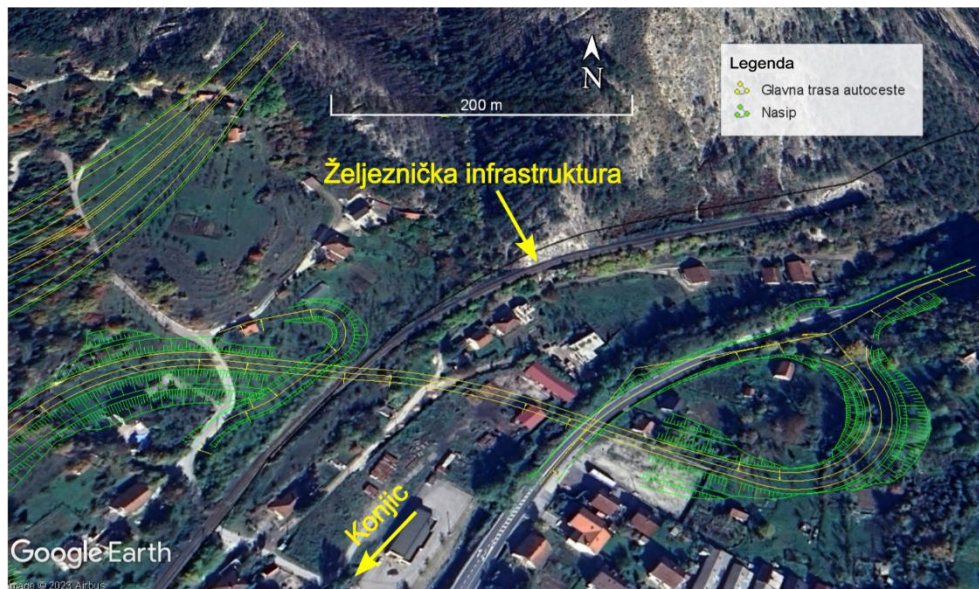
Slika 68: Željeznička infrastruktura presječena vijaduktom između petlje Ovčari i prilaznog puta autoceste
