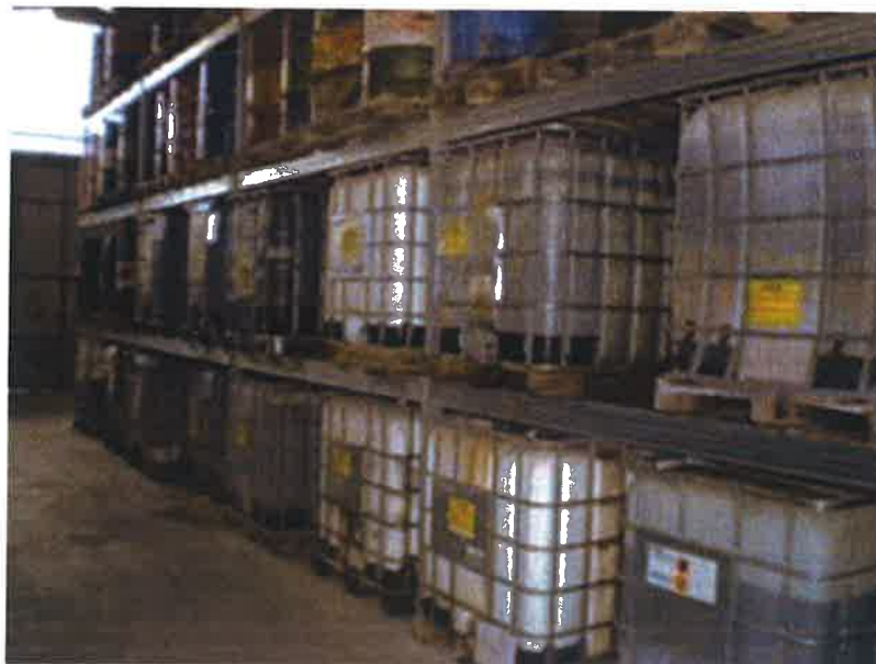
Slika 4 Primjer skladište opasnog otpada
