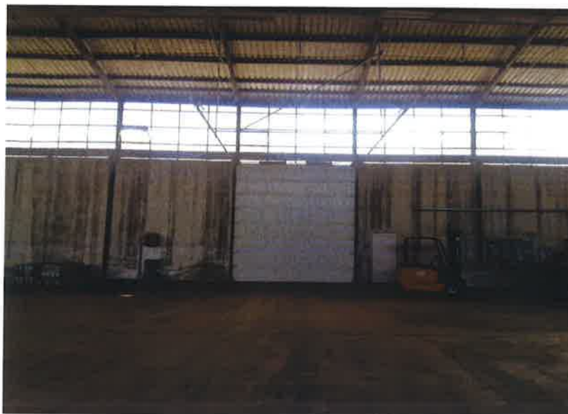
Slika 2 Unutrašnjost skladišta za skladištenje opasnog i neopasnog otpada
