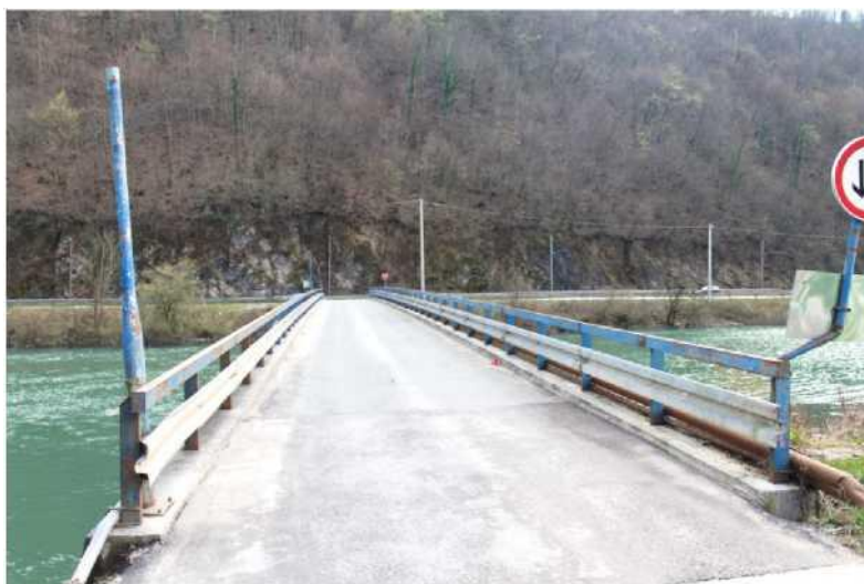
Slika 18. Pogled na armirano-betonski most koji vodi prema putu M14
