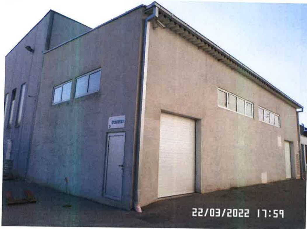
Slika 9 Delakirnica predmetnog postrojenja
