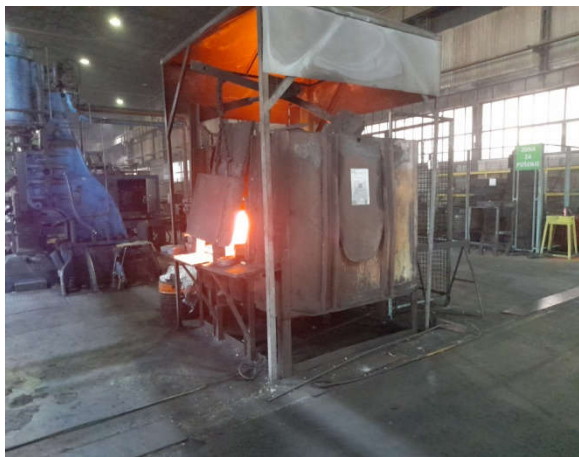
Slika 6. Peć za termičku obradu
