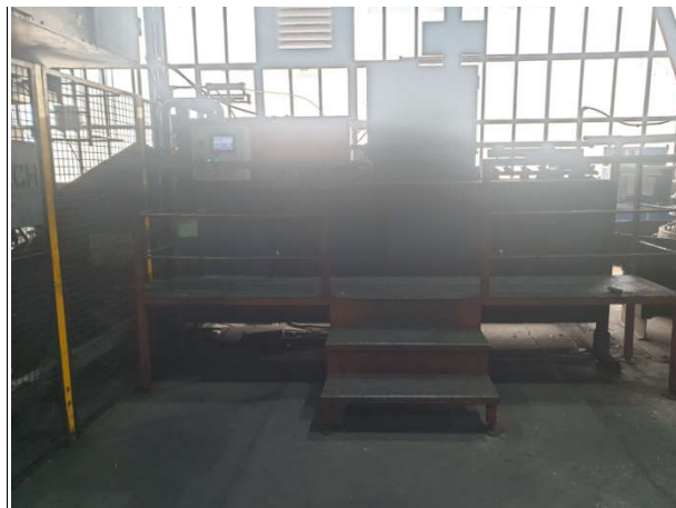
Slika 7. Peć za termičku obradu
